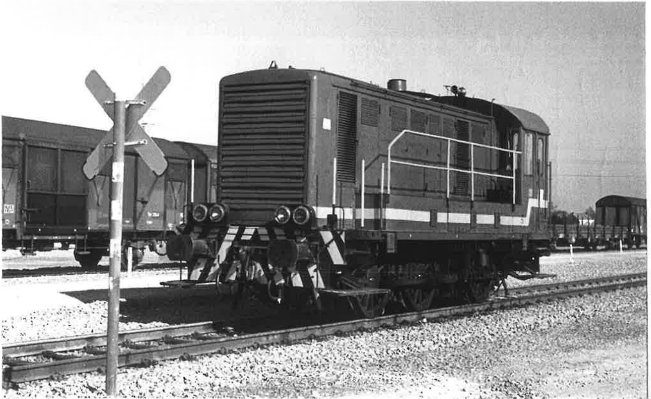
L'ex 8503 de la SNCB rachetée par LOCOREM est à disposition de Tuc-Rail sur la nouvelle base de travaux de construction de la L4 à Antwerpen-Noord. Le 18/03/03 – photo Guy Bridoux.
